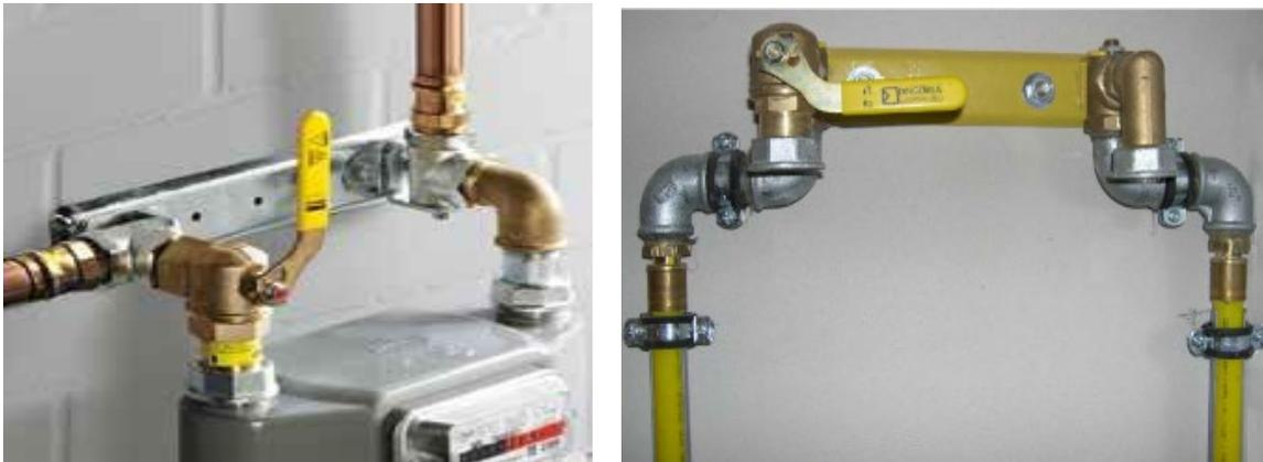
Zur Gewährleistung eines korrekten Einbaus des Gaszählers bei der Verwendung von Kunststoffleitungen bedarf es, auf Grund der geringeren Steifigkeit des Materials, besonderer Aufmerksamkeit. Es wird eine Installation nach Abbildung 8.3 empfohlen.
