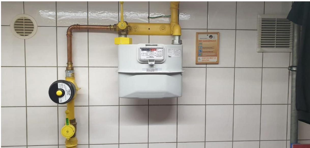
Der Hausdruckregler wird durch den NB installiert. Zur Ausführung kommt in diesen Fällen ein einstufiges Gasdruckregelgerät zum Einsatz und wird in ein Passtück nach der HAE platziert.
