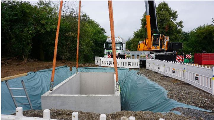
Bildunterschrift: Im Cube befindet sich zukünftig die Schaltzentrale der kalten Nahwärme Rödgens. Bild: Stadtwerke Bad Nauheim, zum Abdruck frei
